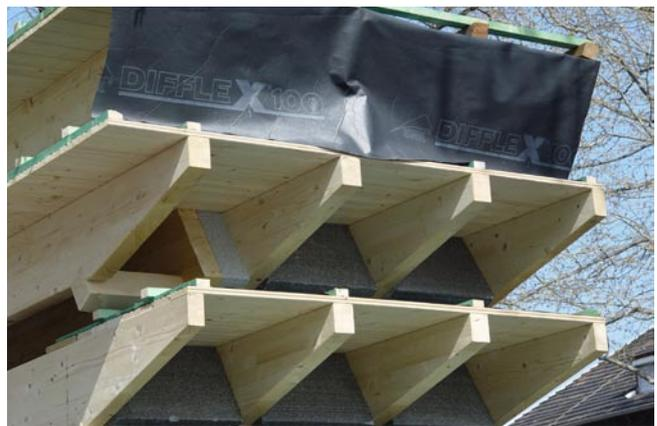
Durch die Verwendung von industriell vorgefertigten und komplett gedämmten Bauelementen, lassen sich auch bei hohen Dämmstärken die Kosten im Einzelfall sogar senken; hier: Dachelemente mit einer 35 cm starken Dämmung aus Polystyrol zwischen den Sparren.
