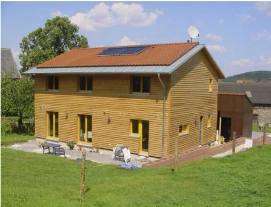
Die Erstellung von NEH in Holzbauweise hat den Vorteil, dass sich auch mit hohen Dämmstärken relativ schlanke Bauteile realisieren lassen. Werden industriell vorgefertigte Bauteile verwendet, sind Preise zu erreichen, die unter denen einer gemauerten Wand liegen können.
