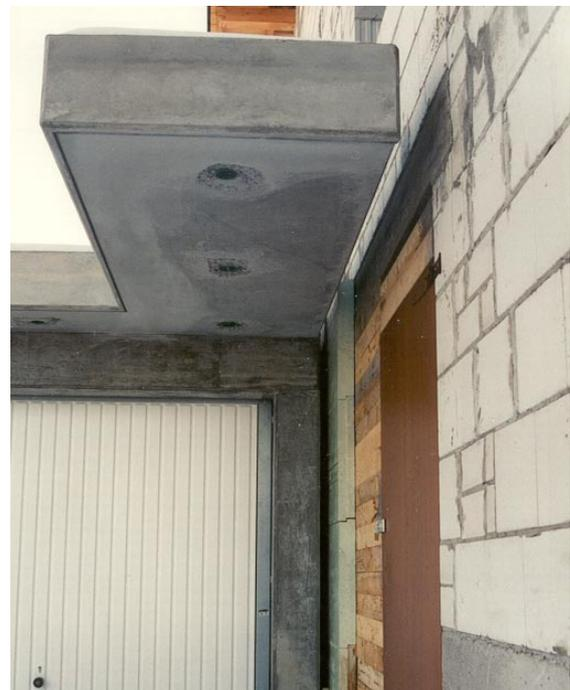
Dieses Bild zeigt gut, wie sich Wärmebrücken vermeiden lassen. Vom Bauherrn wurde ein massives Vordach aus Beton gewünscht. Anstatt dafür die warme Geschossdecke kühlrippenartig nach außen zu verlängern, wurde an das kalte Garagendach anbetoniert. Nach der Fertigstellung von Dämmung und Außenputz ist der Unterschied nicht mehr zu erkennen. Solche pfiffigen Lösungen sind gefragt, wenn wärmebrückenfrei gebaut werden soll.
