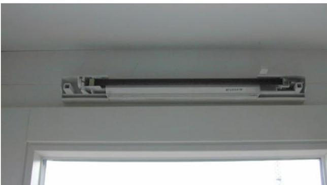
Feuchtgesteuerter Zulufteinlass über einem Fenster (Abdeckung entfernt)
