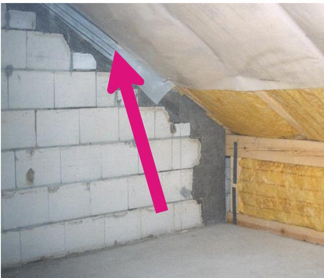
Bewährt hat sich beispielsweise das Einputzen einer Dampfbremse-Folie mit Streckmetall (Dampfbremse ist gleichzeitig Luftdichtung) in den Innenputz der Wände am Anschlusspunkt Dach/ Außenwand. Die Wand wird durch den Innenputz abgedichtet, die Dachfläche durch die Folie.
