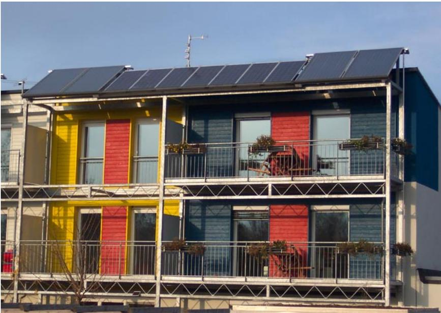
Hier wird die Sonne gleich dreifach angezapft: Durch die großen Fenstertüren erwärmt sie die dahinter liegenden Wohnräume; Photovoltaik und Sonnenkollektoren sorgen für Strom und warmes Wasser.
