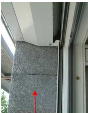
Die 20 cm-Dämmung am Fenster im Querschnitt
