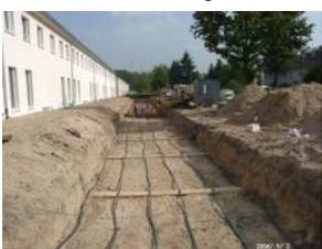
Erdwärmetauscher für die Raumkühlung im Sommer
